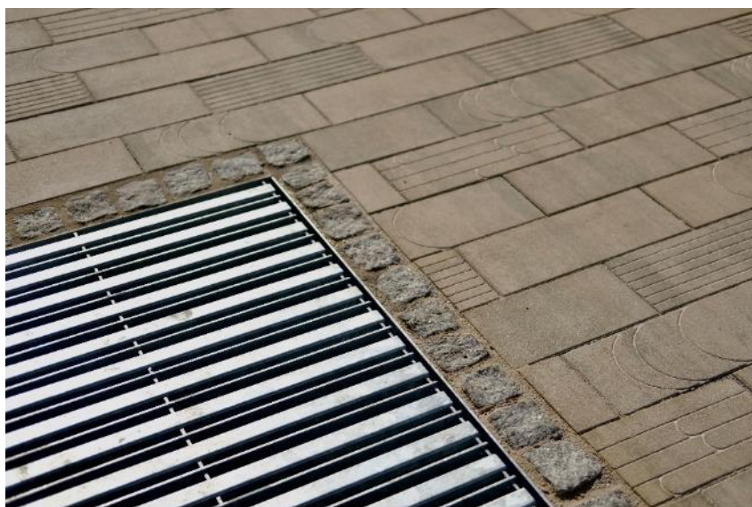
Obrázok 180_Olemovanie stromovej mreže strednou štiepanou dlažobnou kockou – príklad z Mýtnej ulice
